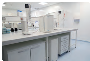
タンクを実験台下に設置
