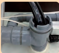
排水接続例 分岐排水口使用例
